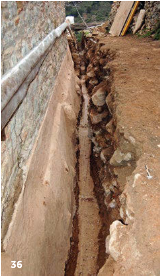
36. Κατασκευή αποστραγγιστικής τάφρου στα θεμέλια λίθινου κτηρίου, στη φάση σοβατίσματος - μόνωσης των θεμελίων.
