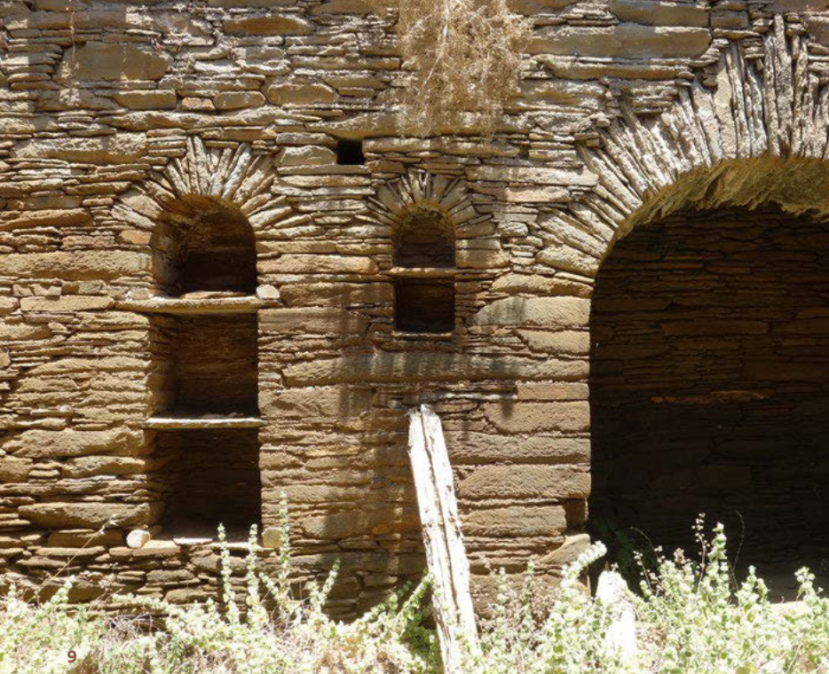
9. Εσωτερικό ξερολιθικού κτίσματος στην Άνδρο.
