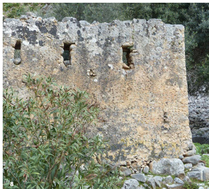
8. Αγία Ρουμέλη Σφακίων. Παλιό επίχρισμα με χαρακτηριστικά χτυπήματα με την άκρη του μυστρίου.
