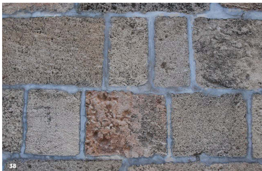
38. Ασύμβατο αισθητικό αποτέλεσμα από τη χρήση κονιαμάτων με τσιμέντο στα τείχη της Ρόδου.
