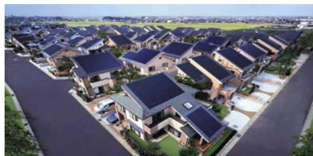
Η ηλιακή γειτονιά στην πόλη Kiyomino της Ιαπωνίας με εγκαταστάσεις 237 kWp σε 80 κατοικίες μια γειτονιάς
